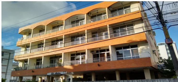
Foto 29 - Fachada Leste do Edifício MÍSTIC
